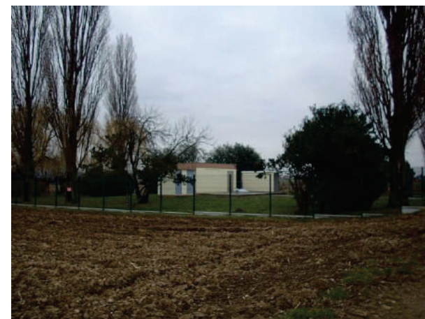
Figure 41 : Captage d'eau potable de Lampertheim
