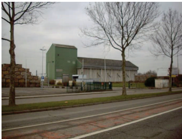
Figure 180 : Silos du Comptoir Agricole
