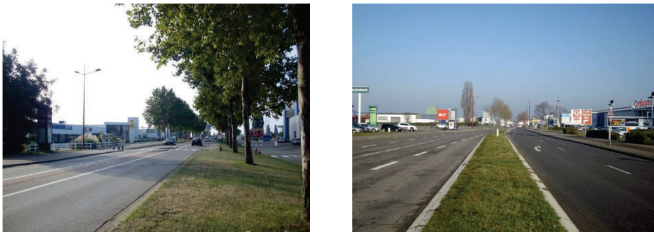
Figure 174 : Vues le long de la RD263
