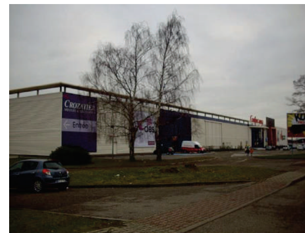
Figure 163 : Vitrines commerciales le long de la RD263
