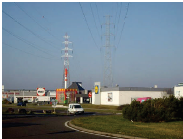
Figure : Lignes de transport d'électricité
