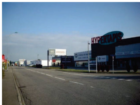
Figure 117 : Bâtiments du faubourg commercial
